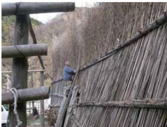
写真 間垣に梯子を立て、ニガタケを上から一本ずつ差し込む
