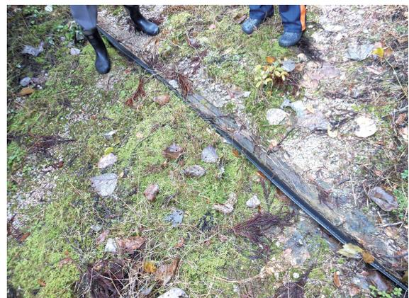
止水堤：このゴムで水を下に流して溝を作らないようにする
